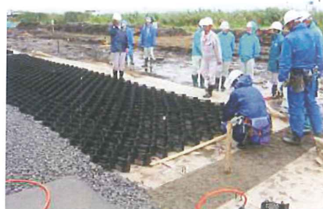
施工写真 上左：端部位置出し 上右：端部固定 下右：セル接続（エアーステープル）
