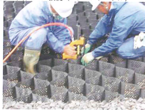
施工写真 上左：端部位置出し 上右：端部固定 下右：セル接続（エアーステープル）
